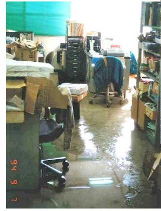
1994.9 台風による水害 (瀬川の事務所)
