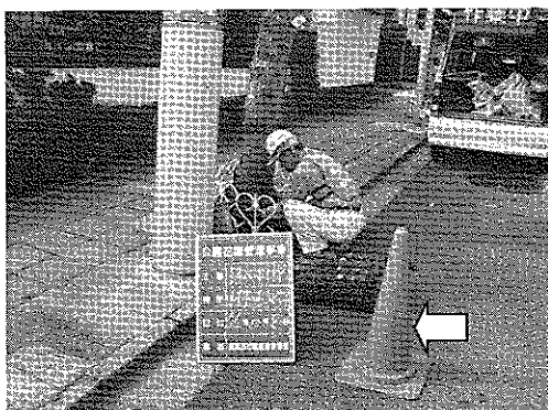
通行車両等から視認しやすくなるための対策 写真1 カラーコーンの設置(写真左)
